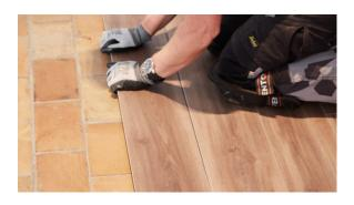
En règle générale, il est nécessaire d'ajuster la largeur la dernière ligne de lames ou dalles pour terminer l'installation. Procédez comme suit: placez une lame ou dalle en superposition de la ligne précédente, placez une autre lame ou dalle en direction du mur (en tenant compte de la dilatation à respecter) et marquez la lame ou dalle à couper. Coupez la lame ou dalle à la bonne taille et ajustez la dernière rangée.
