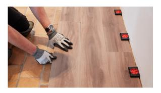
Aux endroits où il est impossible de poser les panneaux LayRed 55 avec la cale de frappe (par ex. contre un mur), vous pouvez les assembler à l'aide d'un tire-lame et d'un maillet.
